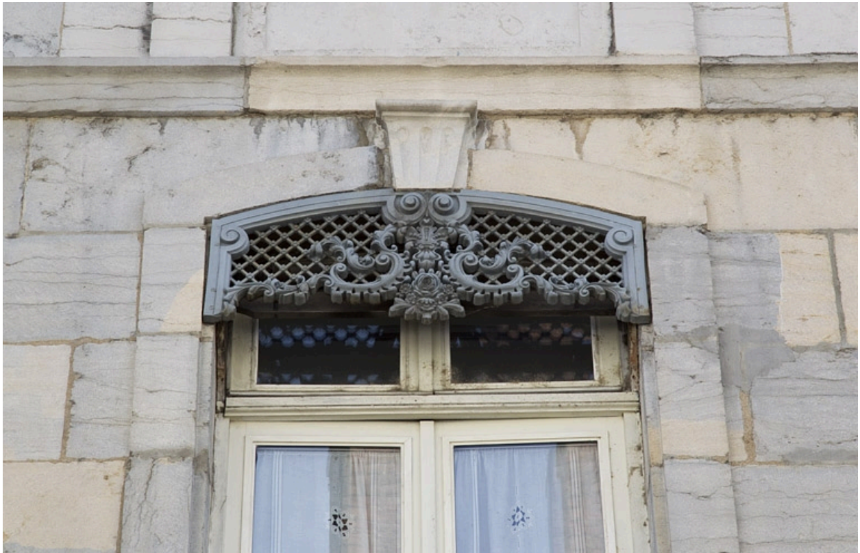
Logis principal, façade antérieure, fenêtre du premier étage : détail d'un lambrequin.
