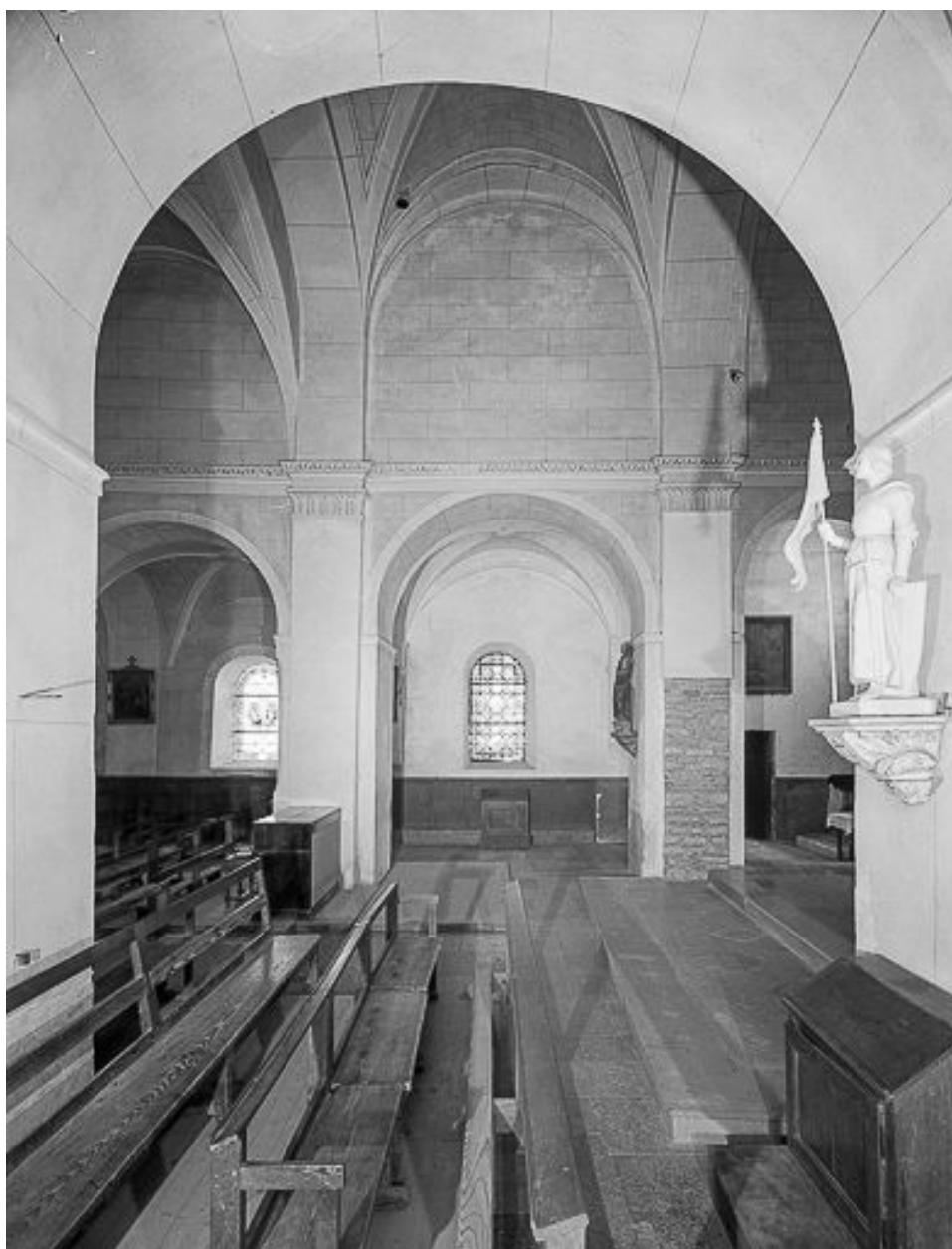
Intérieur : vaisseau central, 4e travée, élévation gauche.
