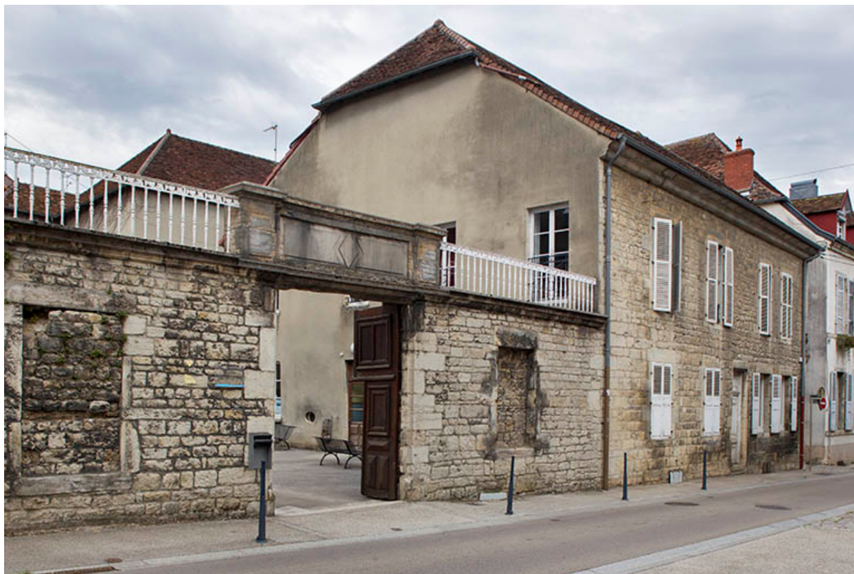
Entrée, rue du collège.
