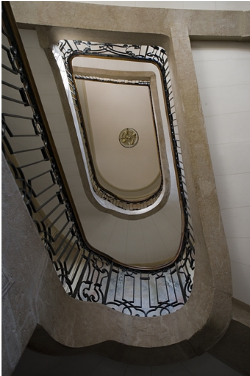
Vue du plafond de l'escalier depuis le rez-de-chaussée.
