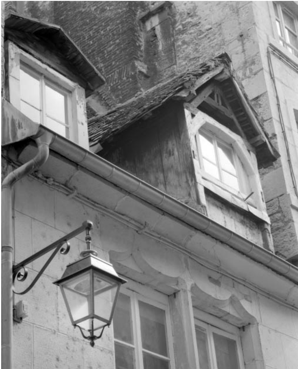
Façade sur rue : détail des lucarnes.
