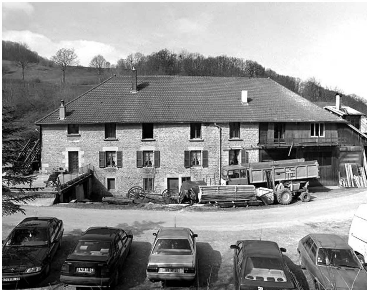
Logement et atelier de fabrication : façade antérieure.
