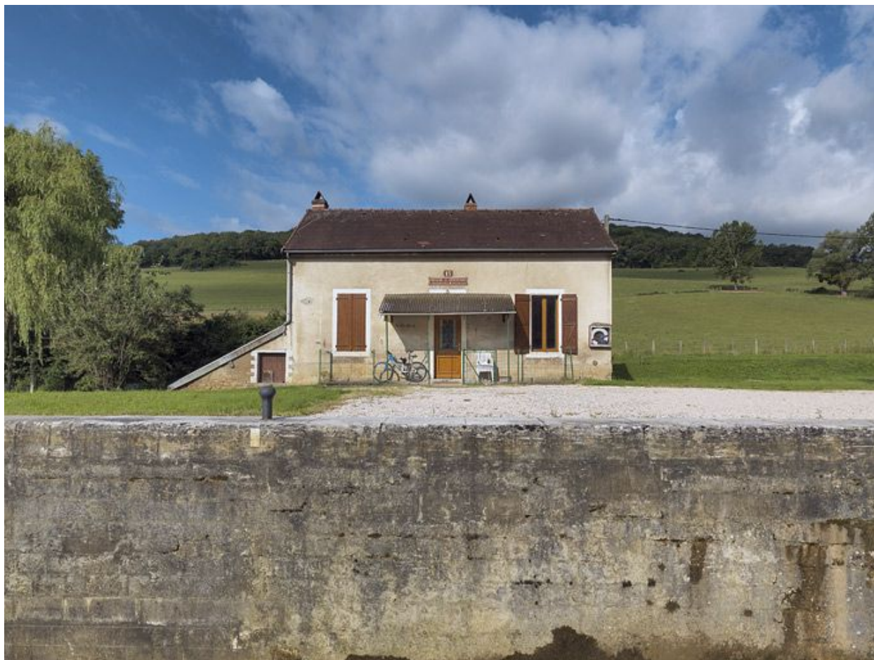
Maison éclusière de face.
