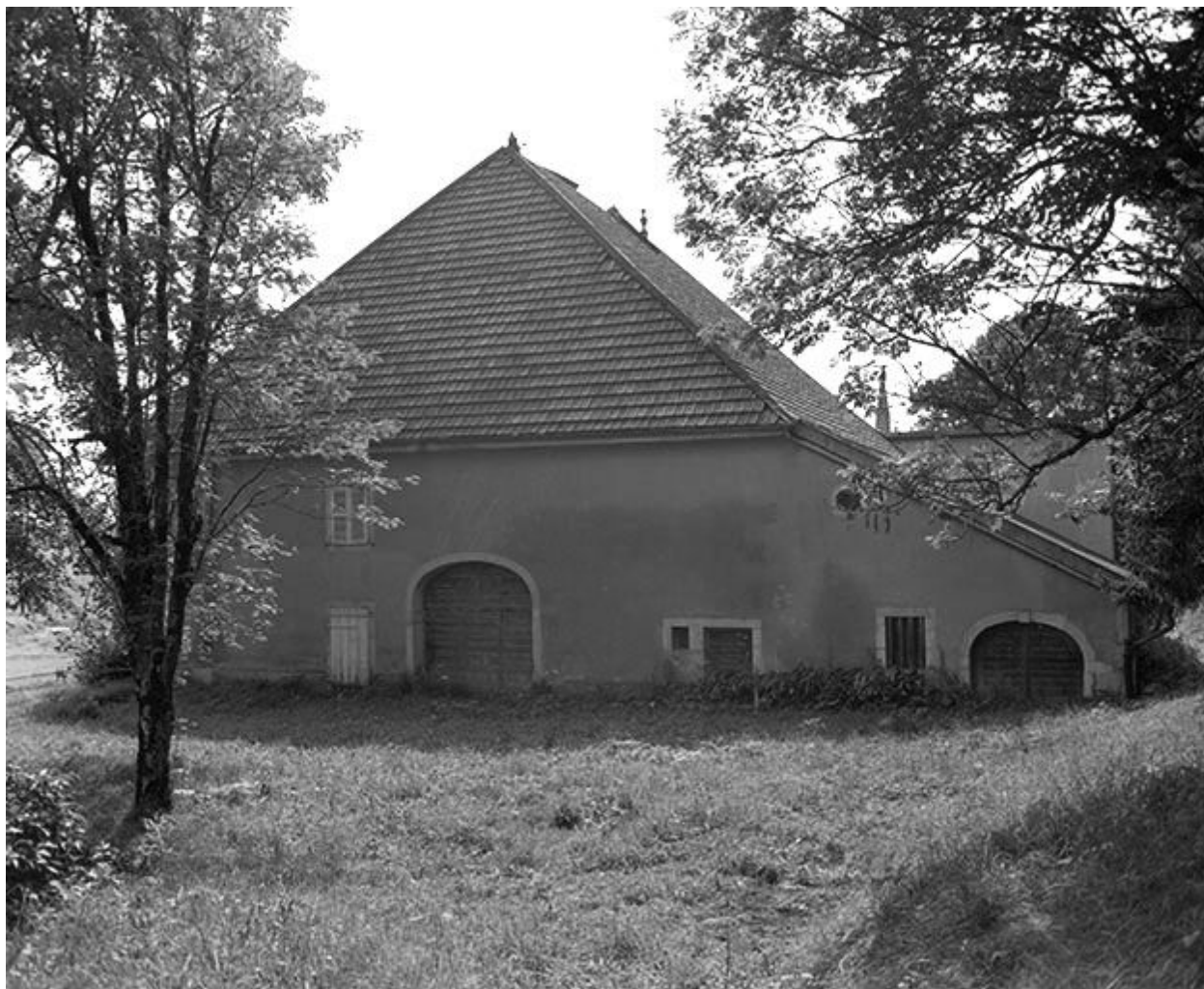
Façade latérale, vue depuis le parc.
