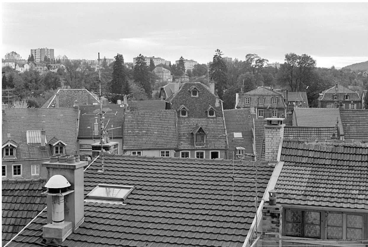
Vue d'ensemble de la toiture.
