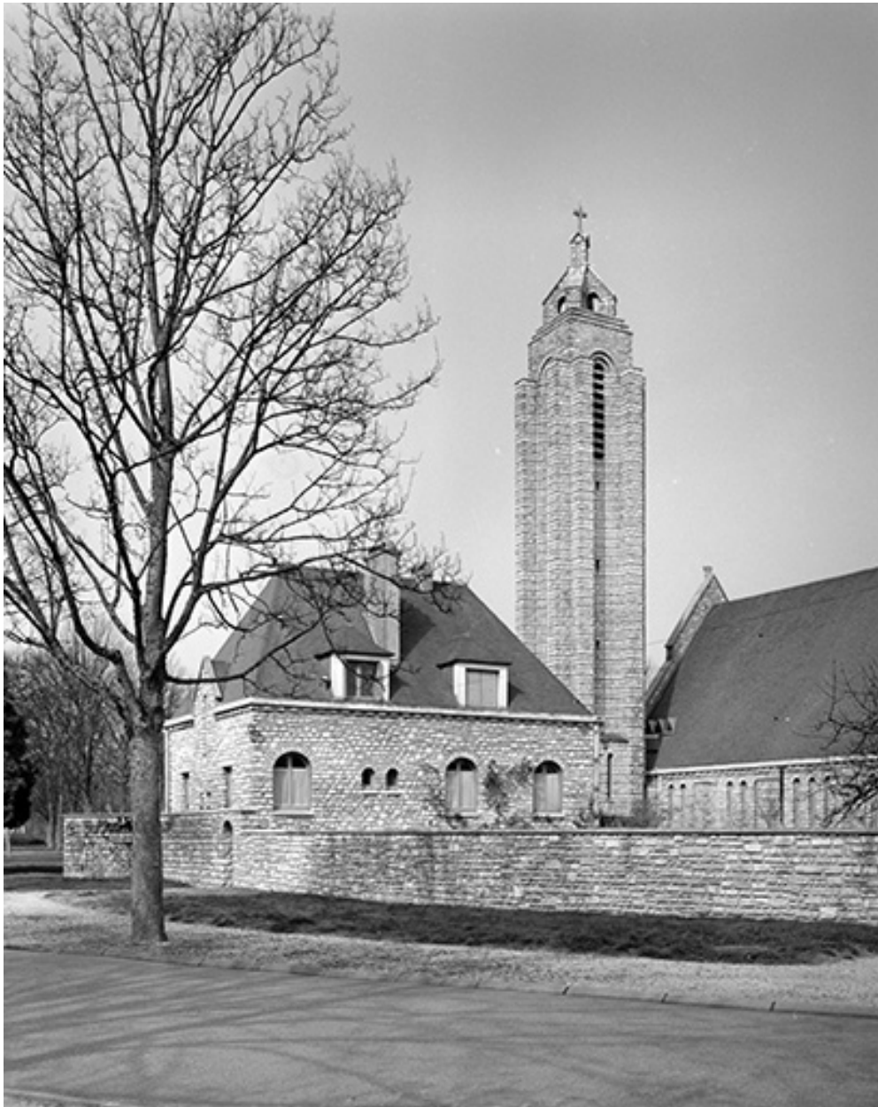
Face postérieure du presbytère et tour-clocher.
