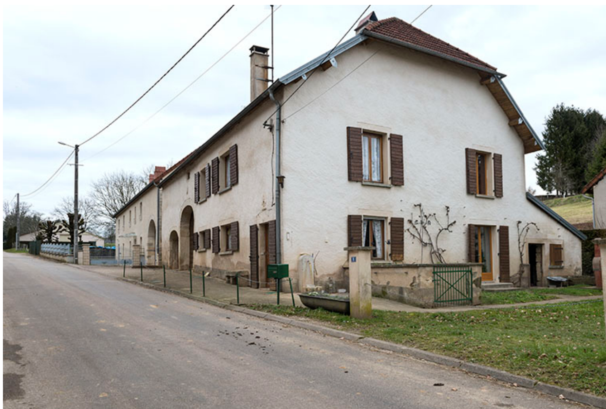
Ferme-bloc, 8 rue de la Garenne.
