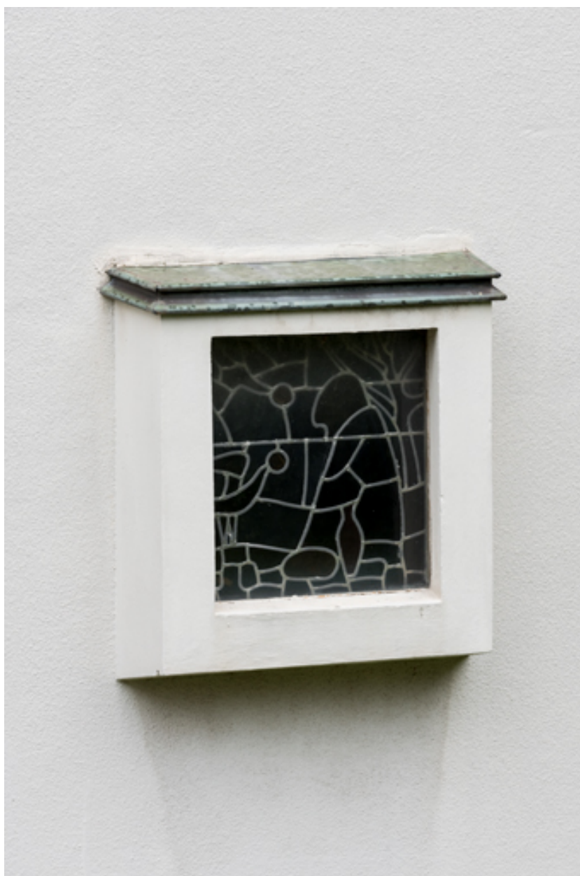
Vue extérieure de la verrière en vitrail (baie 0 - droite).
