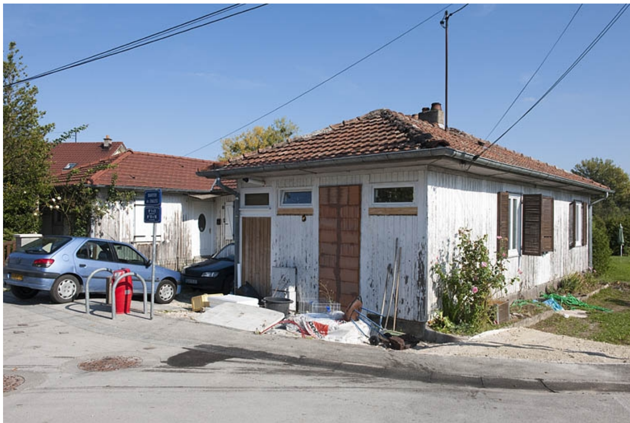
Maison jumelée (n°8-10) vue de trois quarts.
