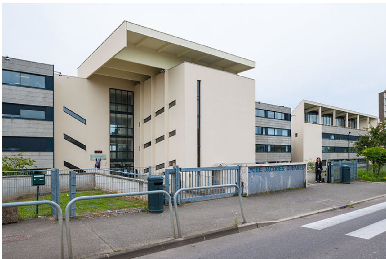
Entrée principale : détails.
