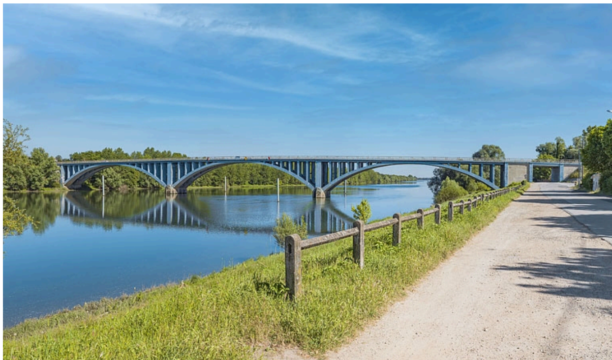
Vue d'ensemble du pont de Lacrost, d'amont, depuis la rive droite.
