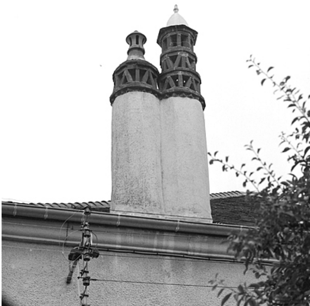
Souches de cheminée.
