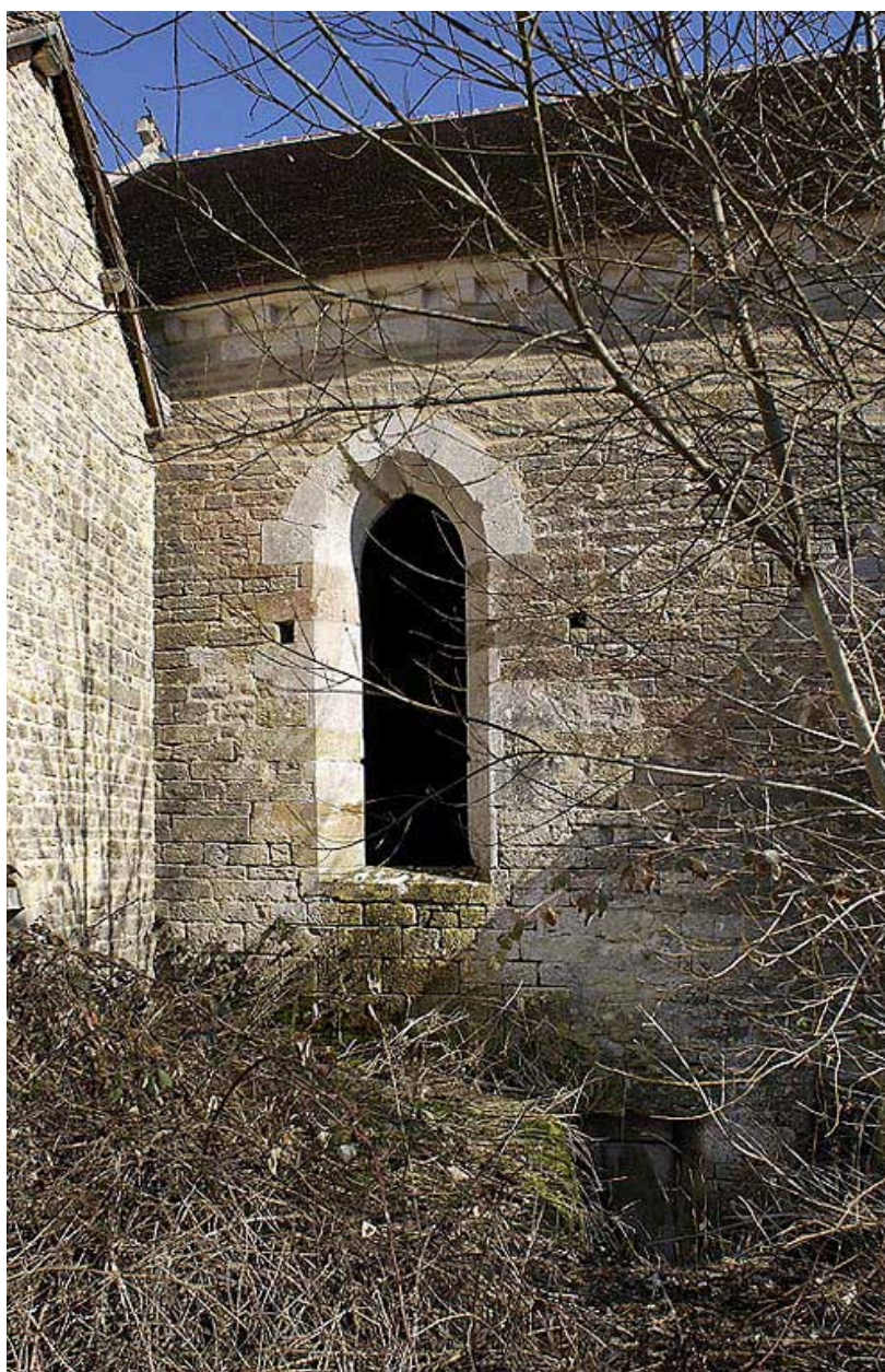
Cellier : élévation ouest, fenêtre et ancienne porte d'entrée.
