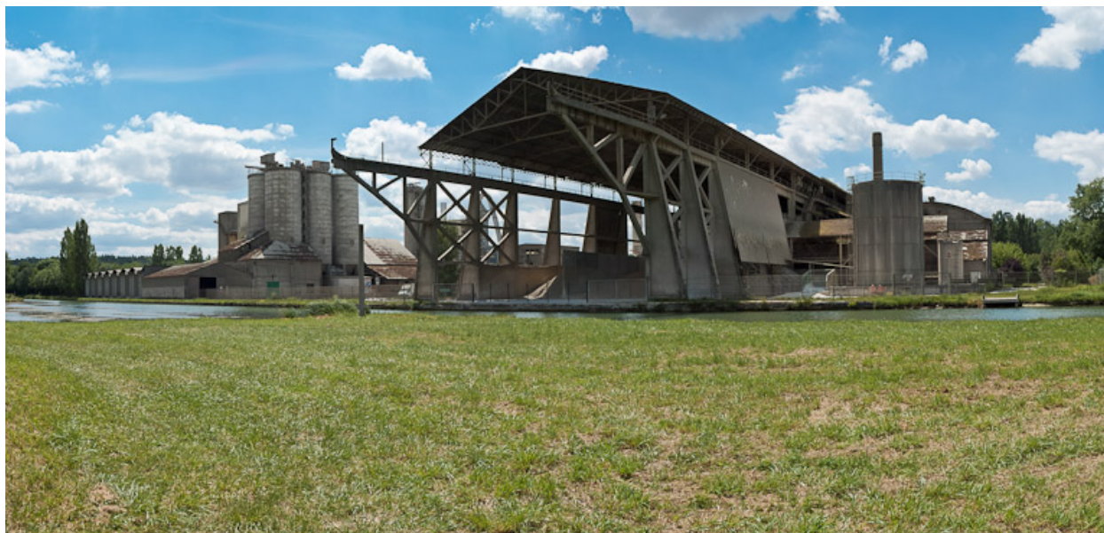
Vue du pont-roulant de la cimenterie.
