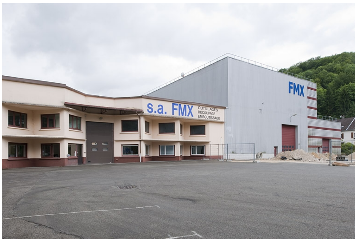
Façade nord des ateliers de fabrication.
