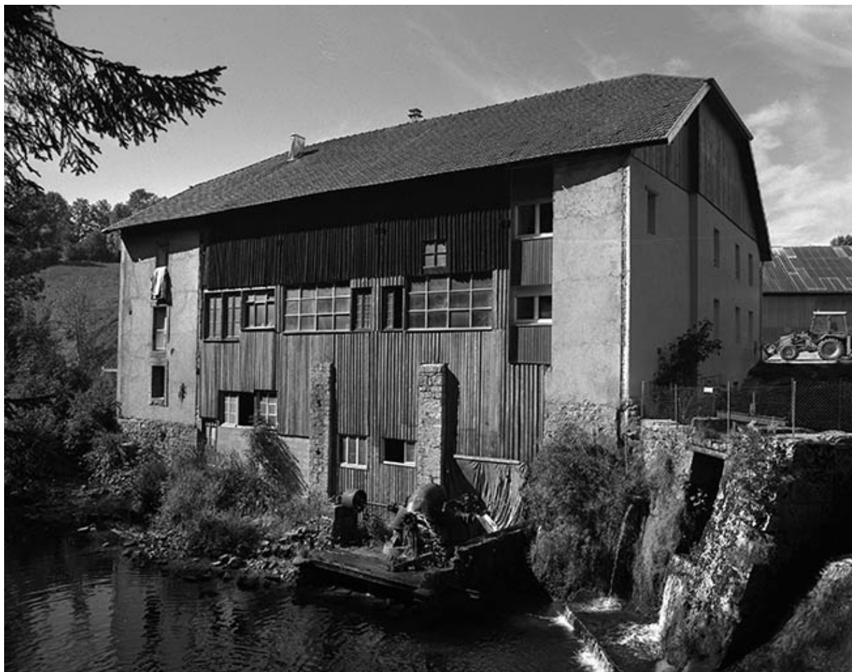
Façade postérieure du moulin Choudet.
