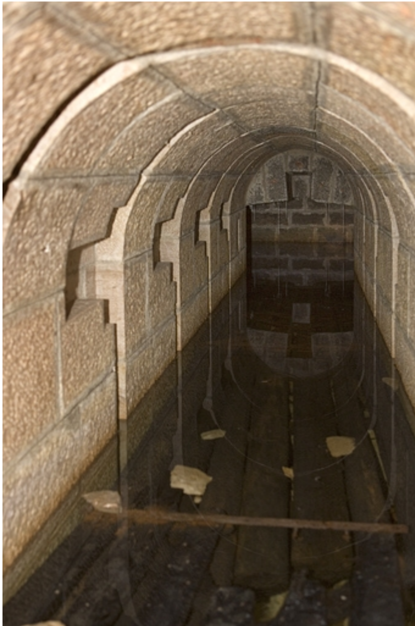
Chambres de mine centrale : galerie inférieure.
