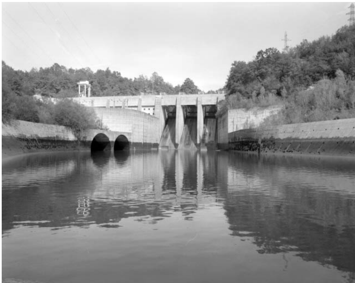
Evacuateur et bassin d'amortissement.
