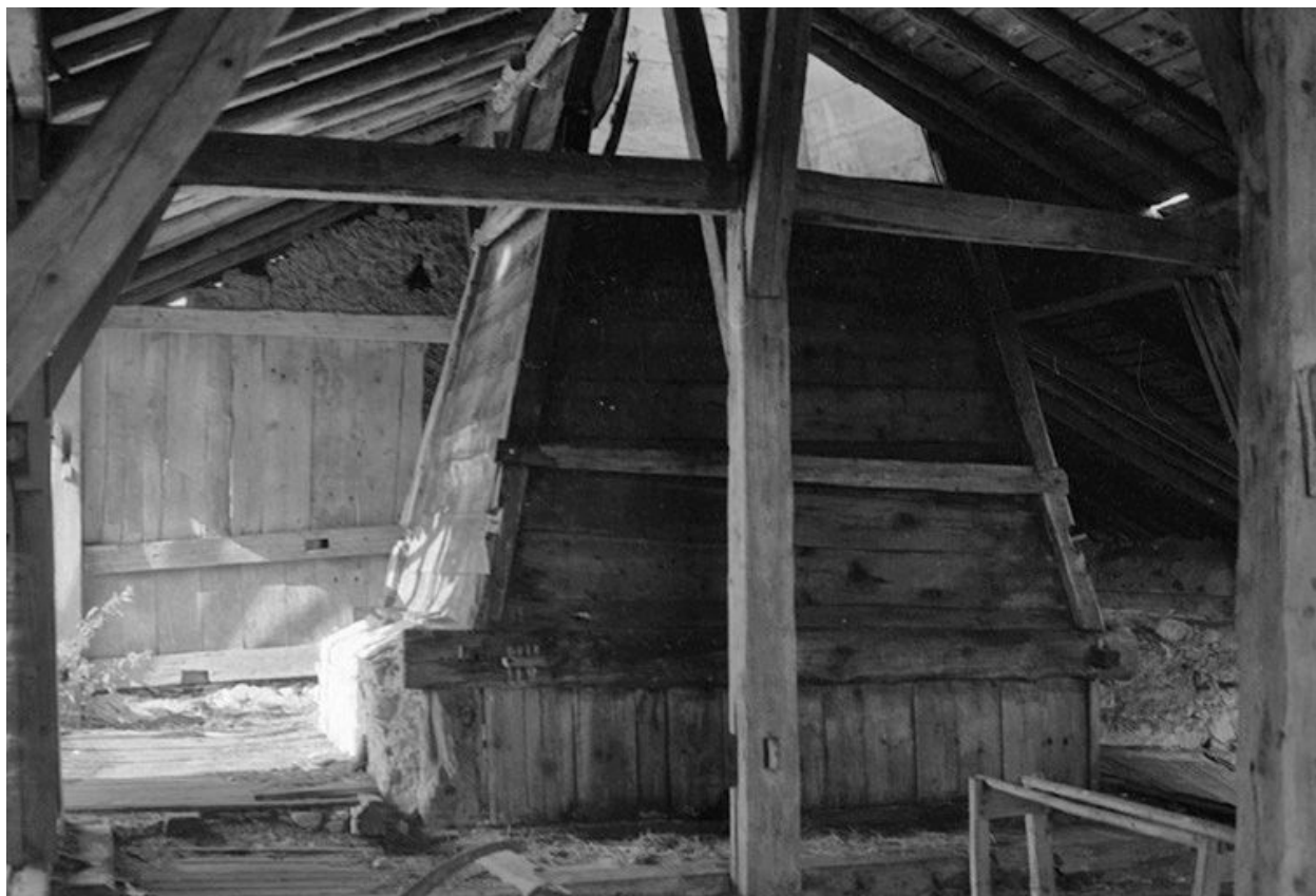
Charpente et "tué".
