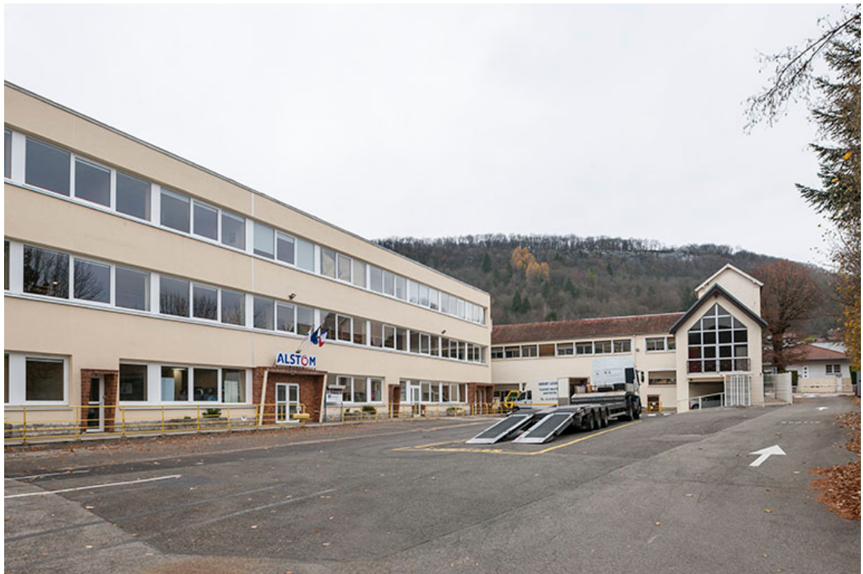
Bâtiment administratif sur la cour.
