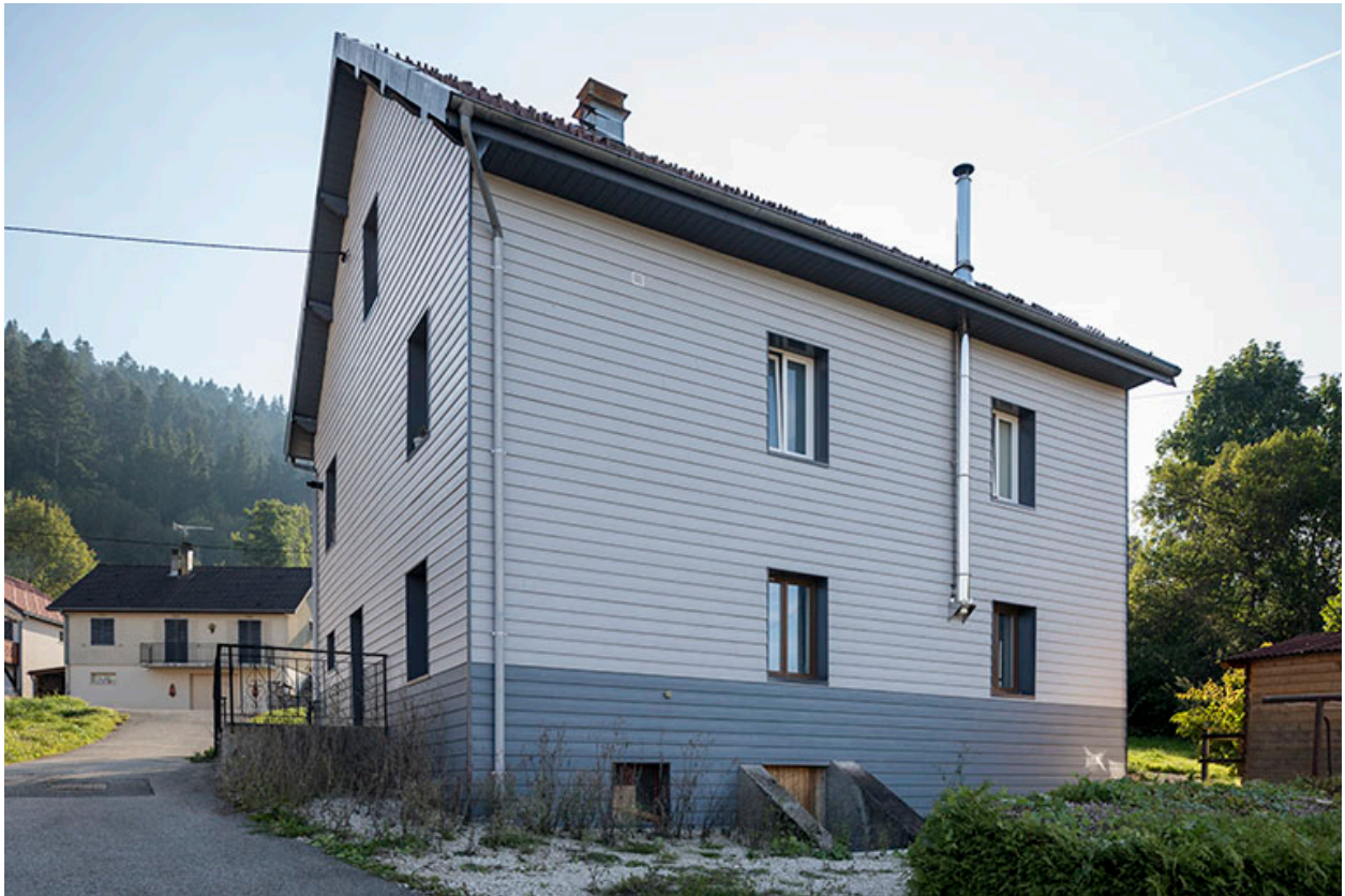
Façades postérieure et latérale droite.
