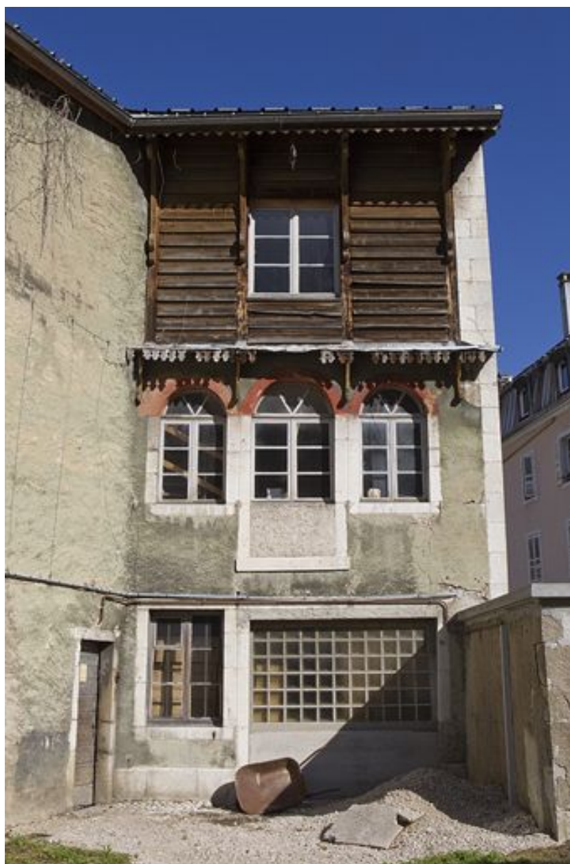
Atelier de fabrication (anciennes écuries et fenil).
