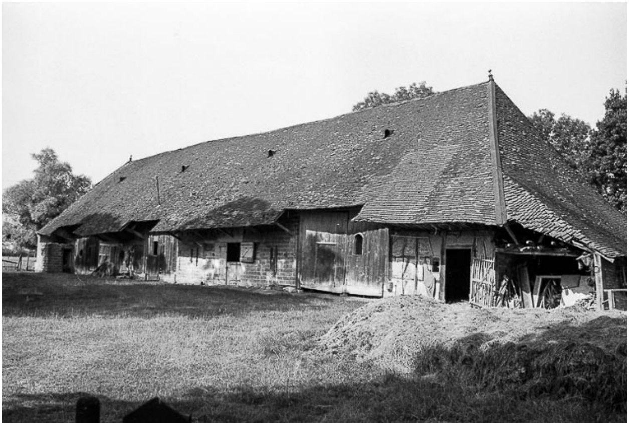
Façade postérieure en 1975.
