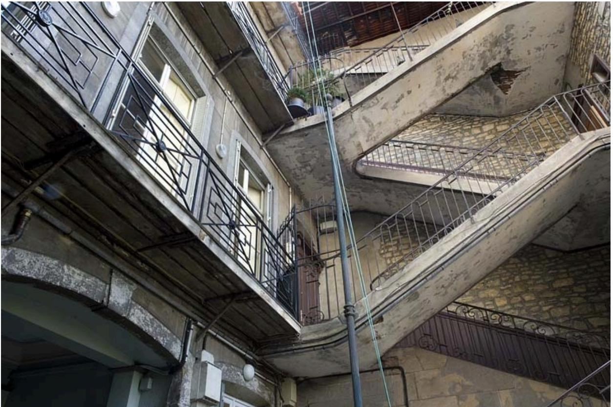
Détail de l'escalier à cage ouverte et d'une coursière sur la façade postérieure du logis principal.
