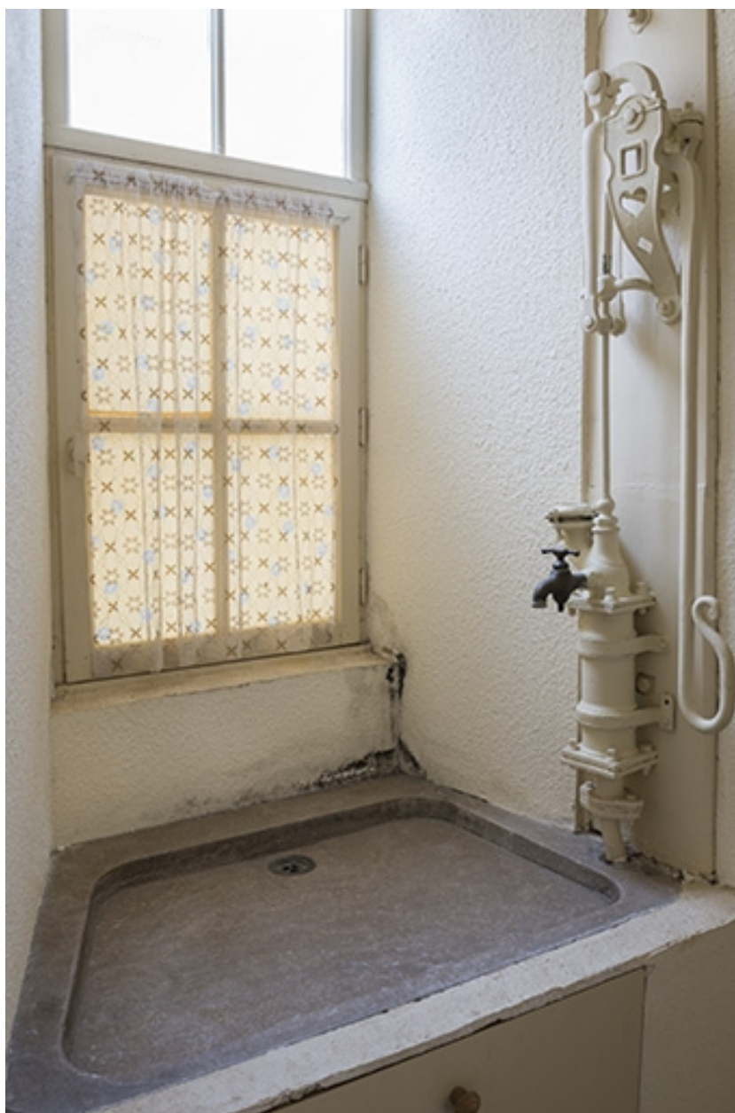
L'ancienne pompe à bras munie d'un robinet au-dessus de l'évier en pierre de la cuisine.
