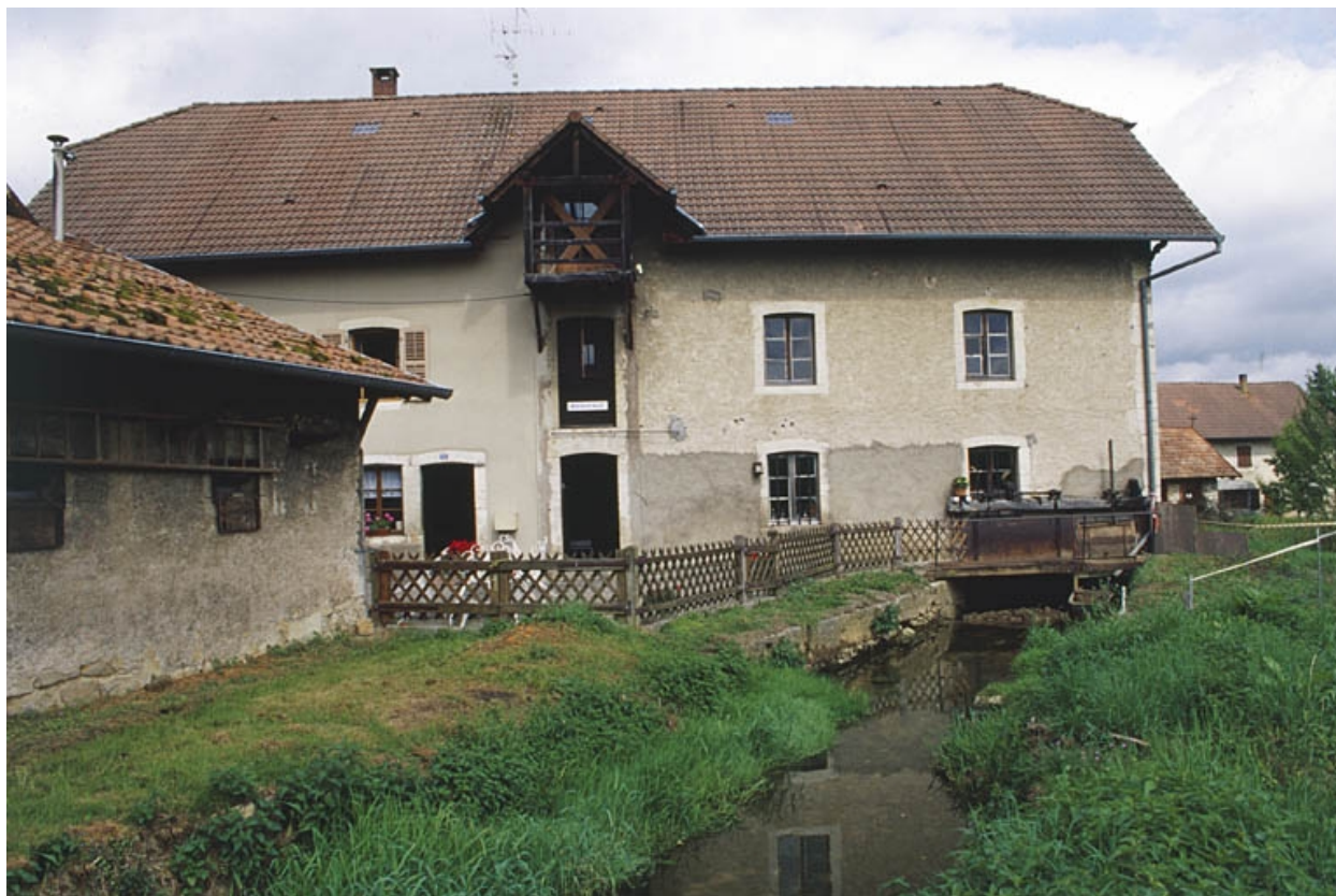
Façade antérieure de la minoterie.
