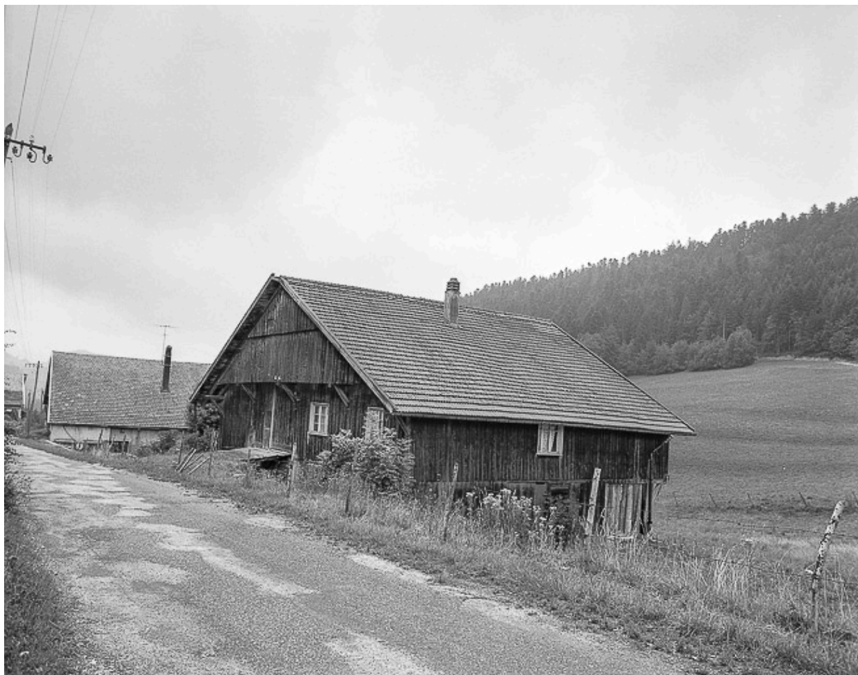
Ferme située au lieudit Le Mont Dessus, cadastrée 1966 D2 40 : façade antérieure.
