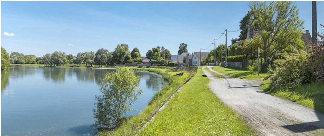
Vue d'ensemble de la digue, prise d'aval.
