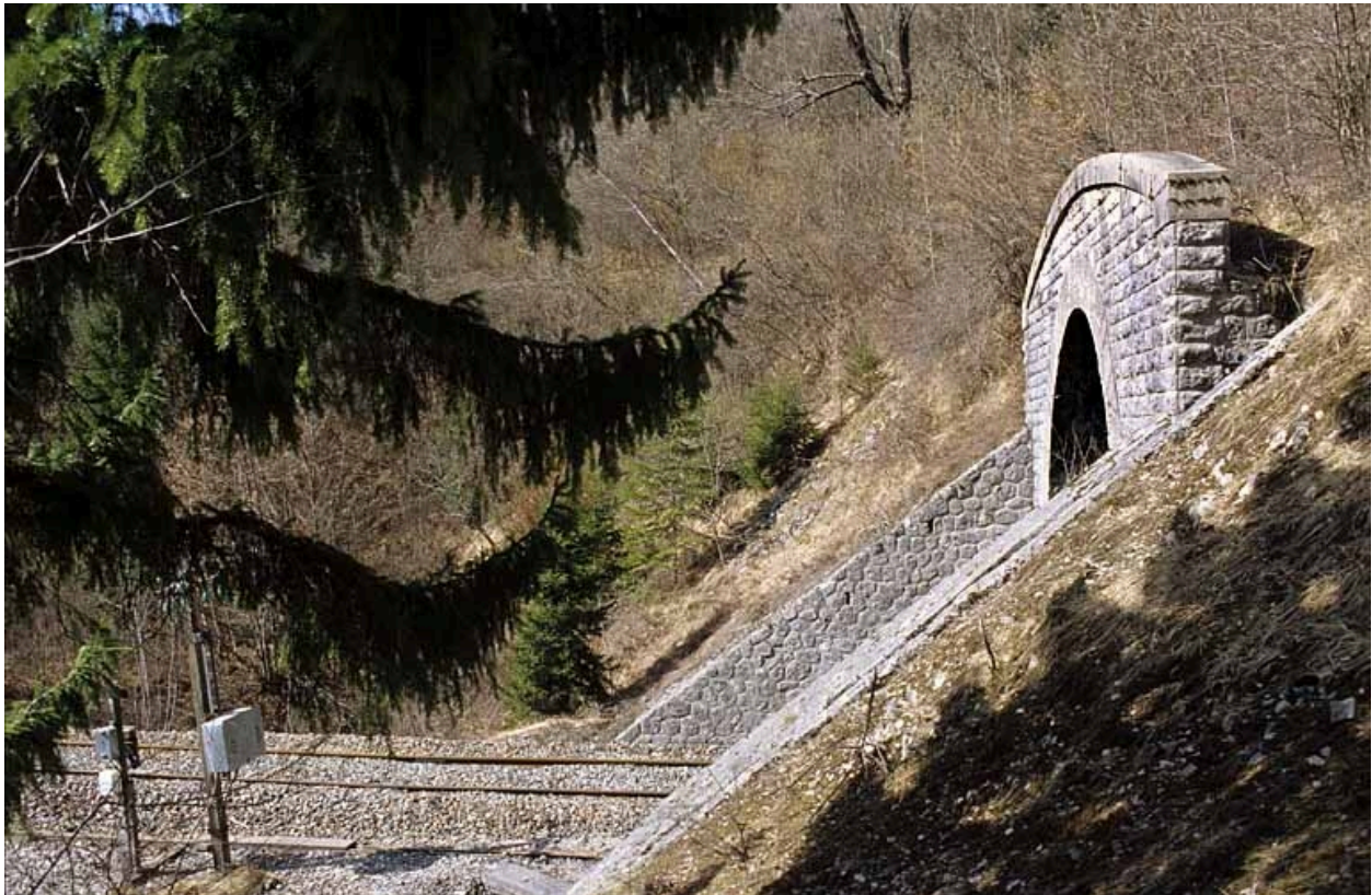
Tunnel : tête côté La Cluse, vue de profil.
