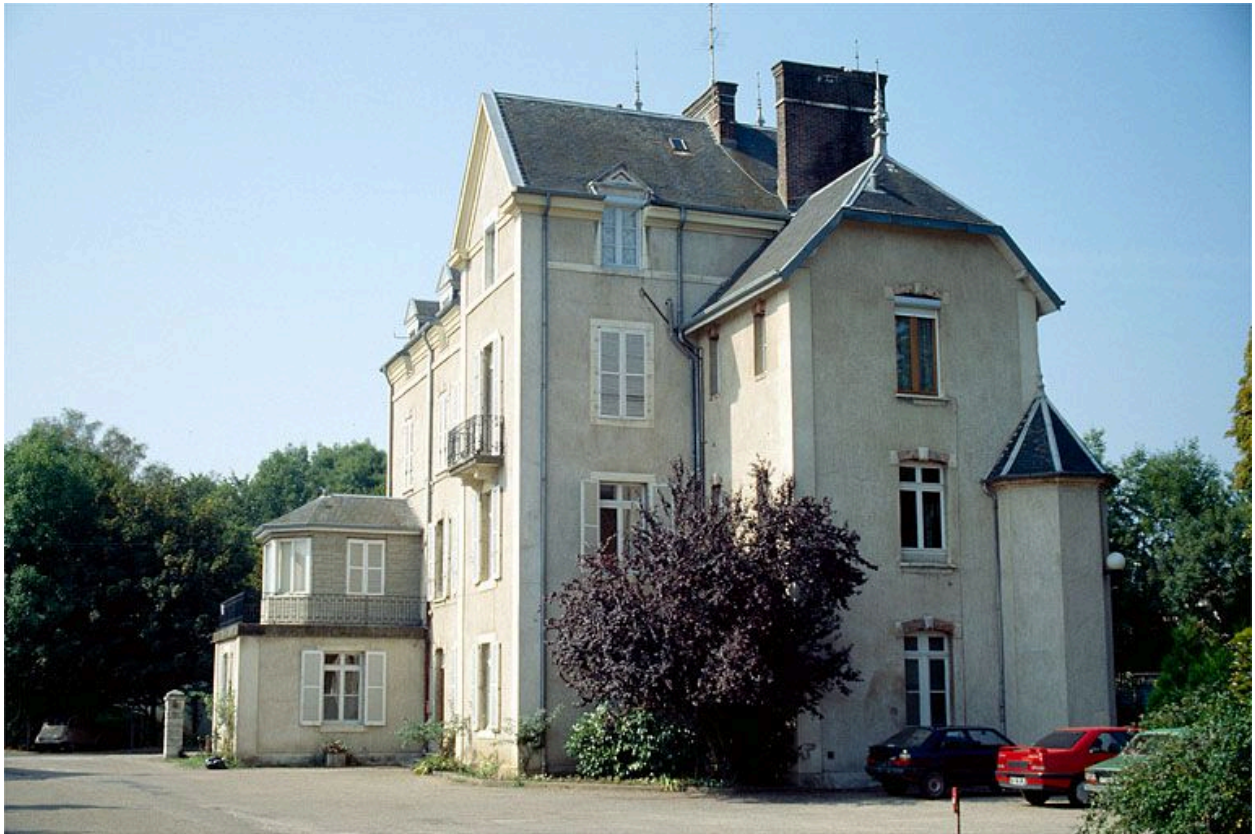
Façade latérale gauche du logement patronal (A).
