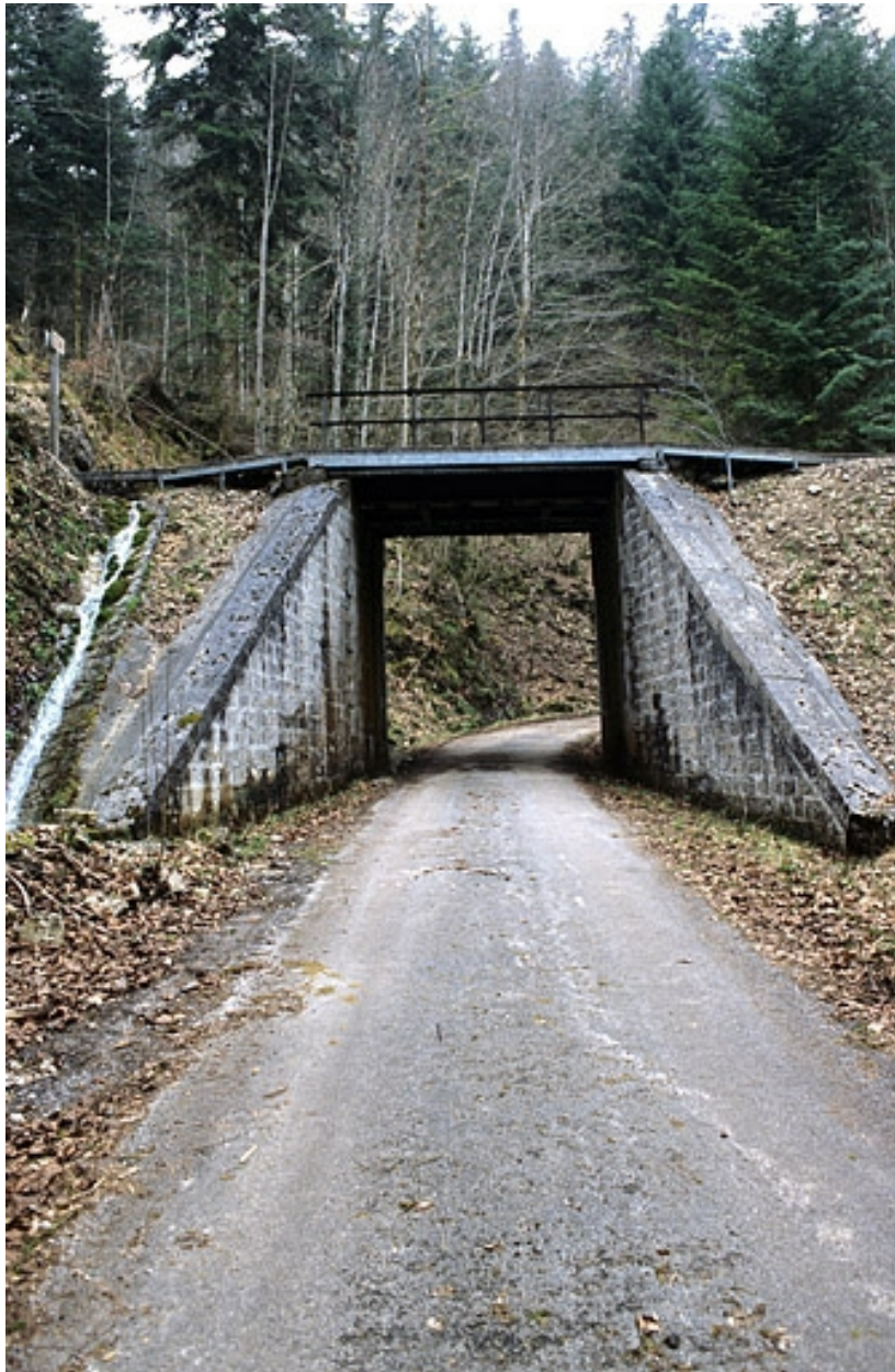
Pont, depuis la route côté vallée.
