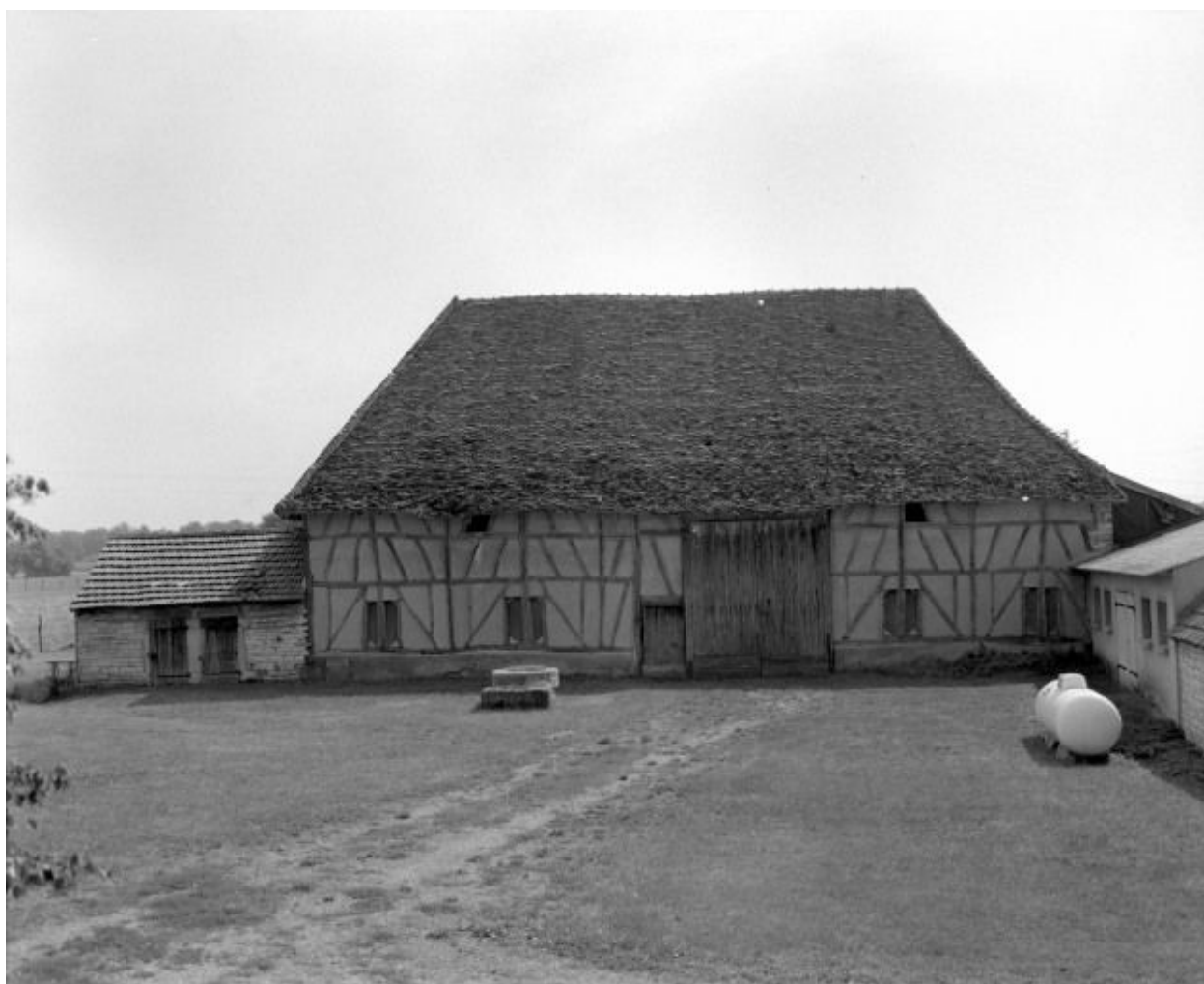
Bâtiment des dépendances d'une ferme située au lieu-dit La Villeneuve.
