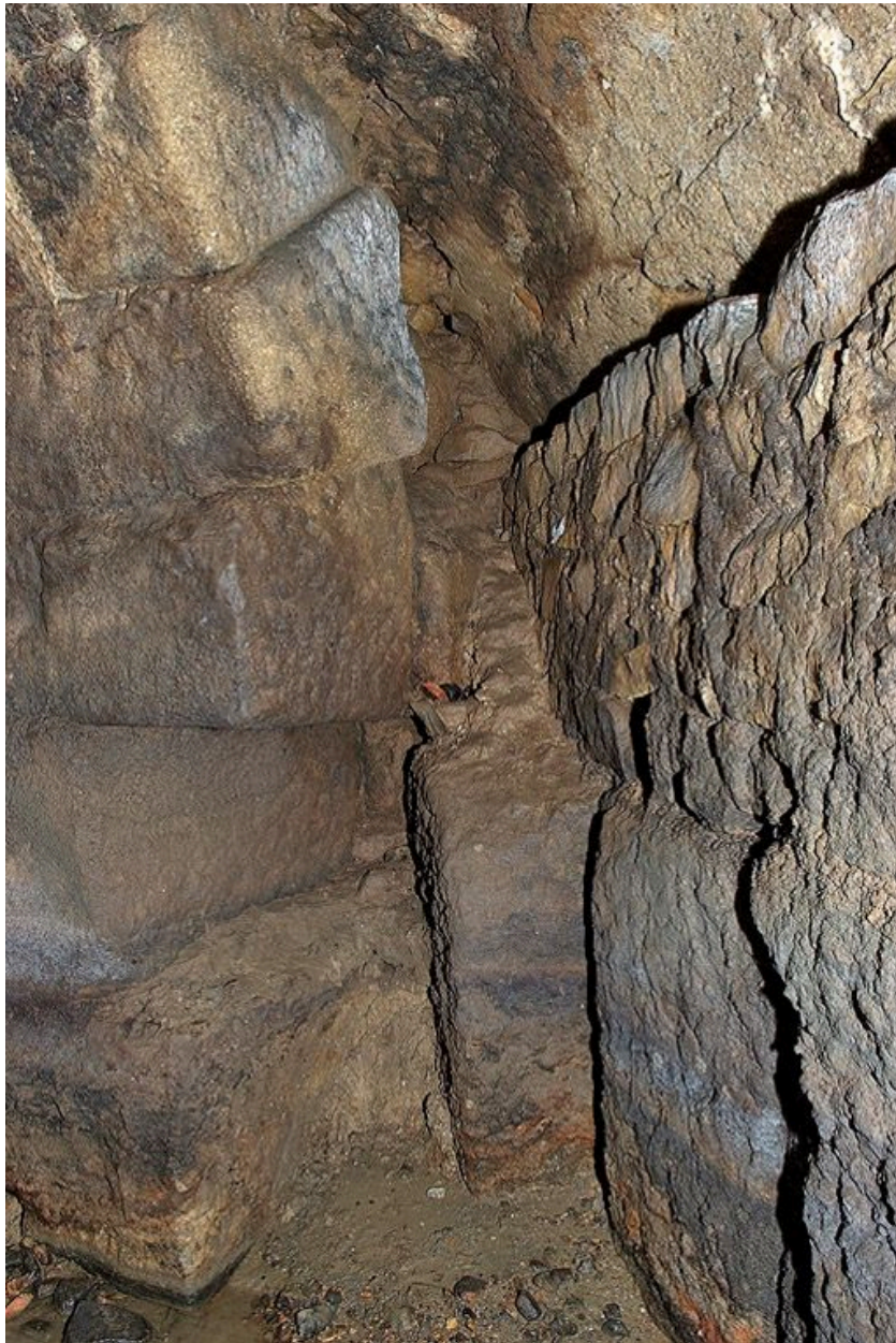
Angle de la section intermédiaire avec l'extrémité de la deuxième galerie.
