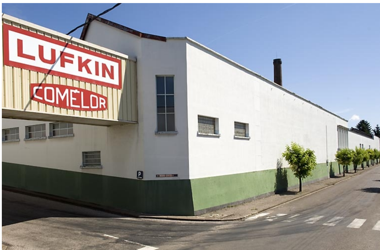
Façade sur rue des ateliers est.
