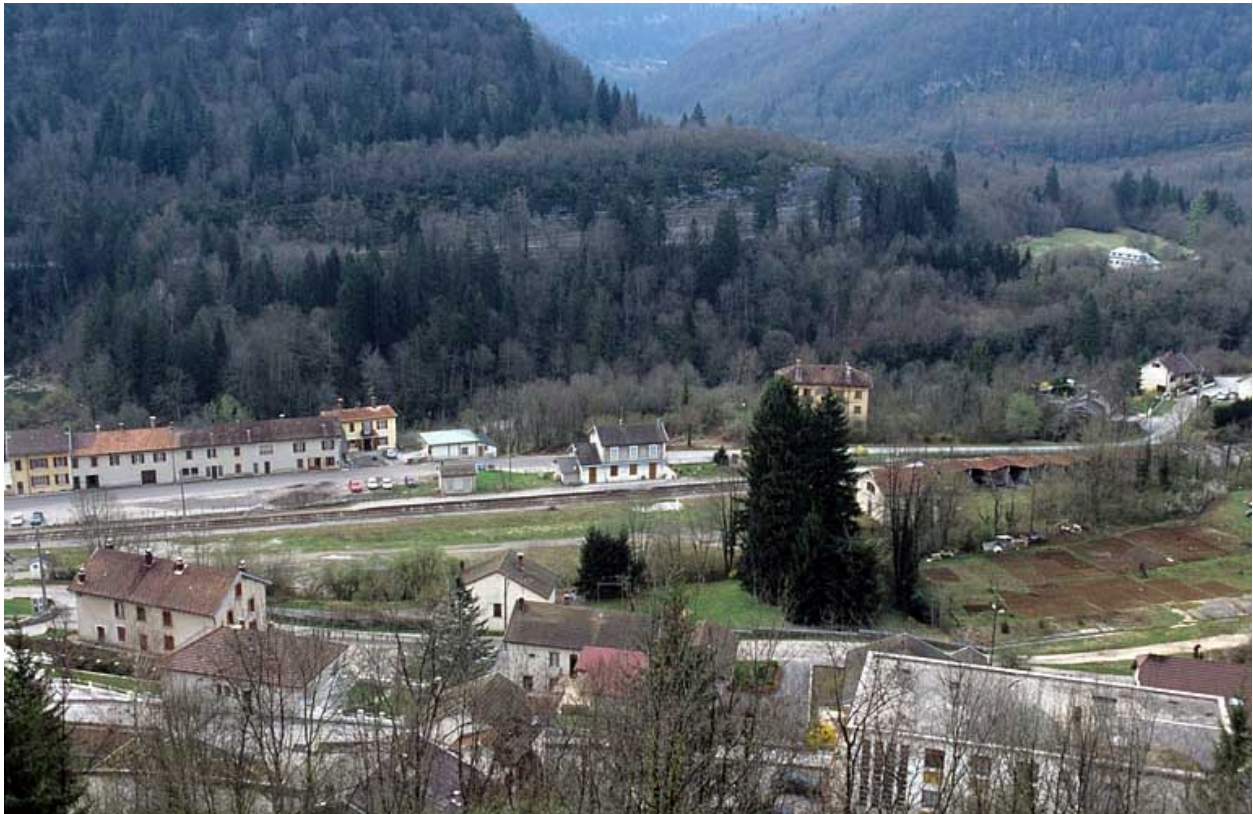
Vue d'ensemble plongeante sur la gare, depuis le nord.
