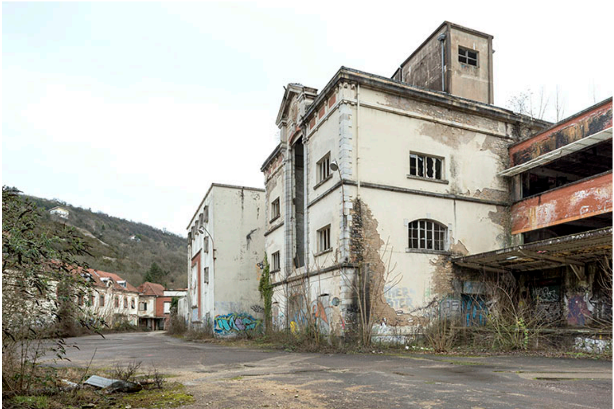
Etat en 2016. Usine A : cantine et étirage tergal, depuis l'ouest.
