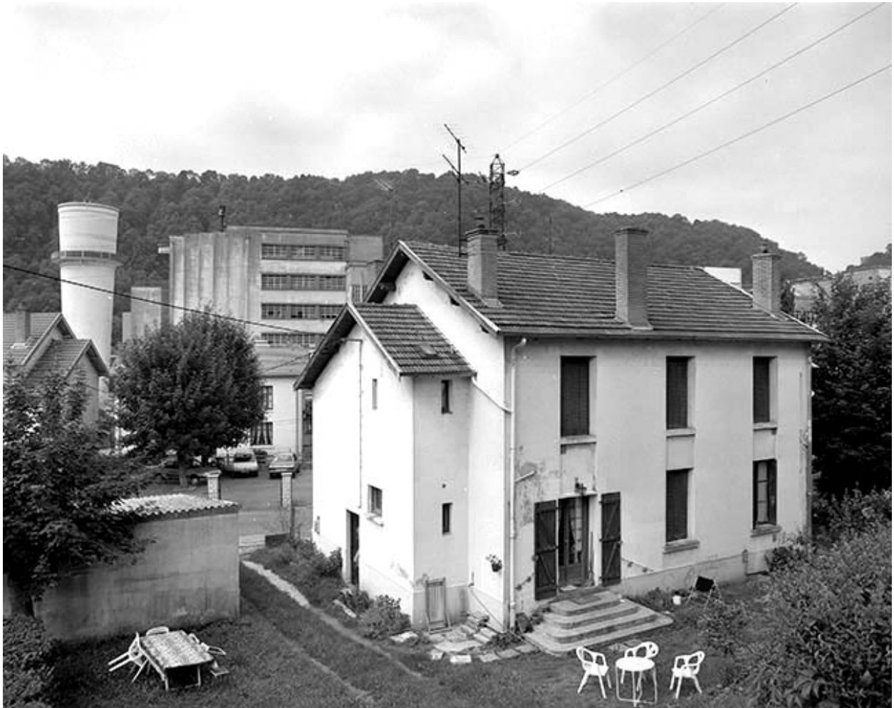
Façade postérieure d'une maison de type II (9, cité Rhodiacéta).
