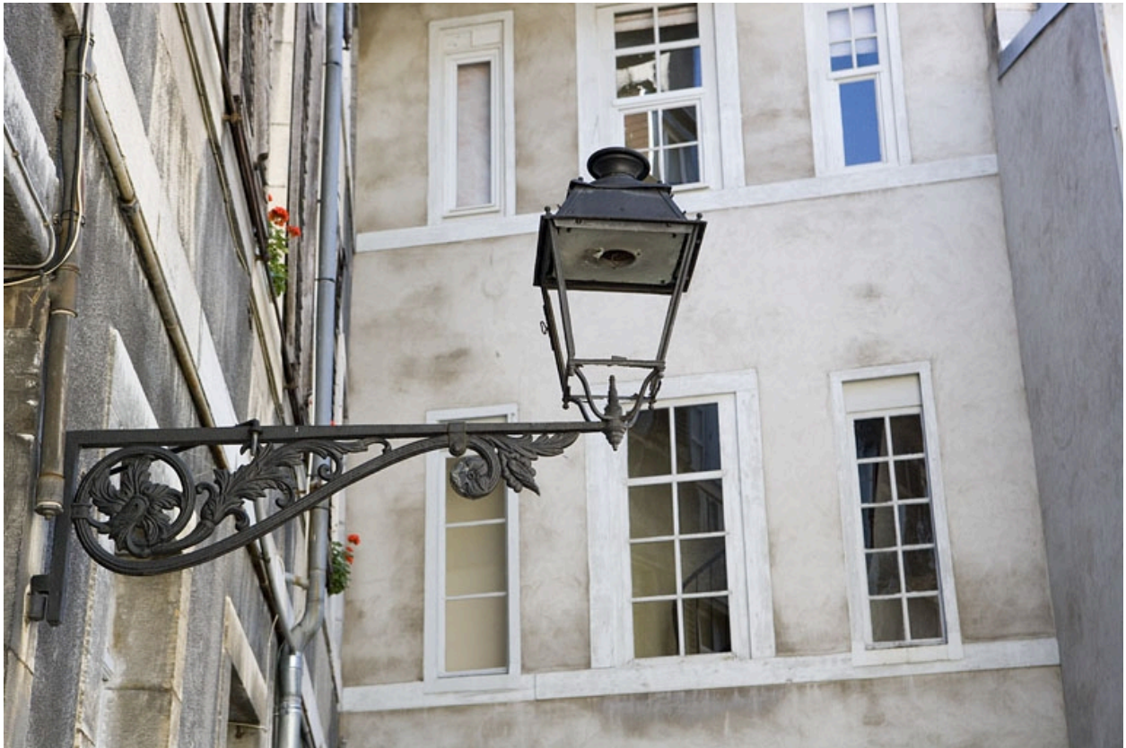
Deuxième cour : détail d'un bec de gaz.
