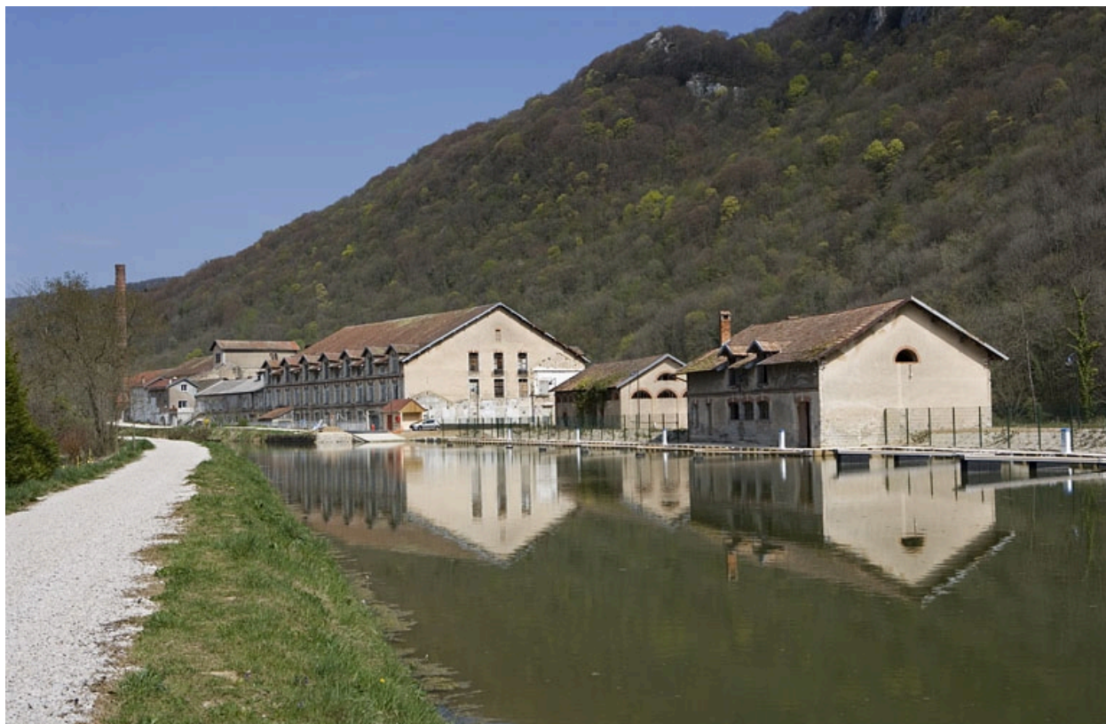
Façades sur le canal de l'atelier de façonnage, de l'atelier de réparation et de l'écurie.
