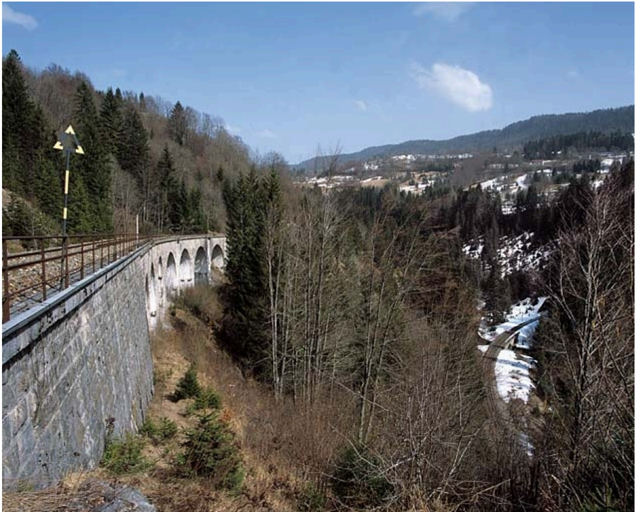
Vue d'ensemble, depuis le sud-ouest (côté Andelot-en-Montagne).
