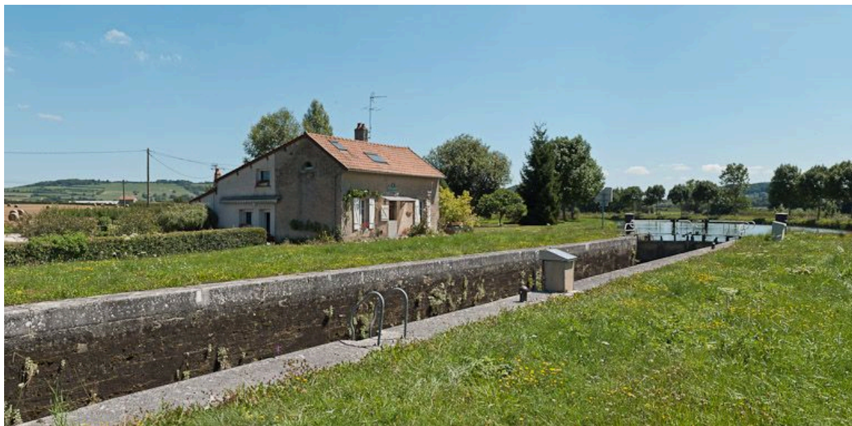
Vue d'ensemble du site d'écluse.
