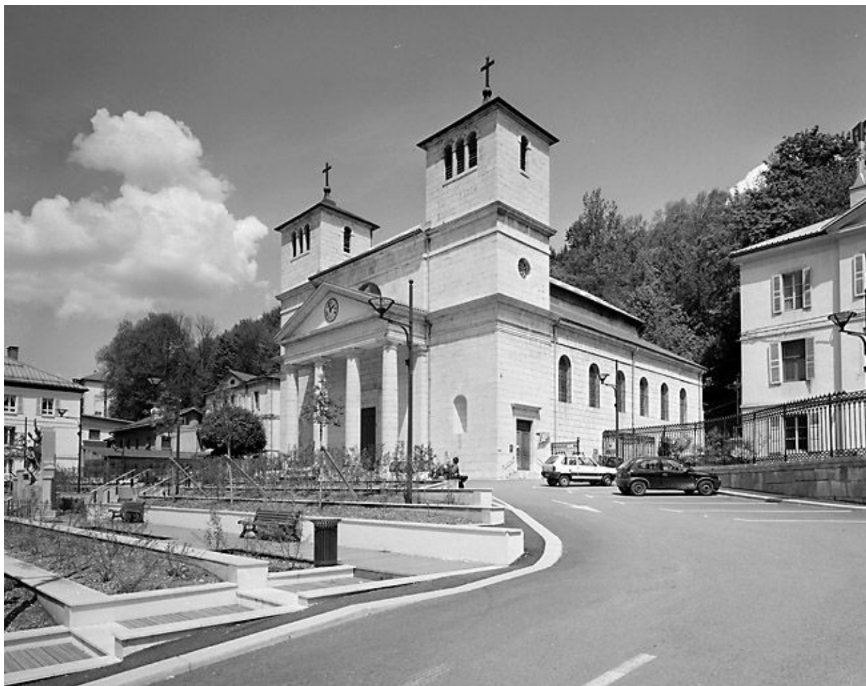
Vue d'ensemble rapprochée, côté est : église.
