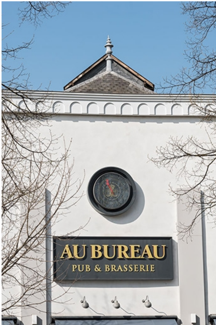
Façade antérieure : décor de la travée centrale.
