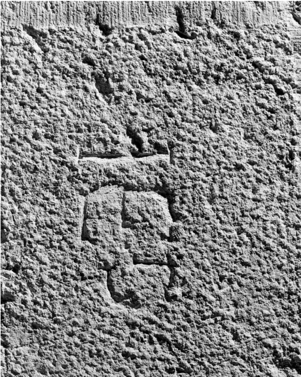
Clocher, 2e niveau : marque de tacheron sur la fenêtre droite.
