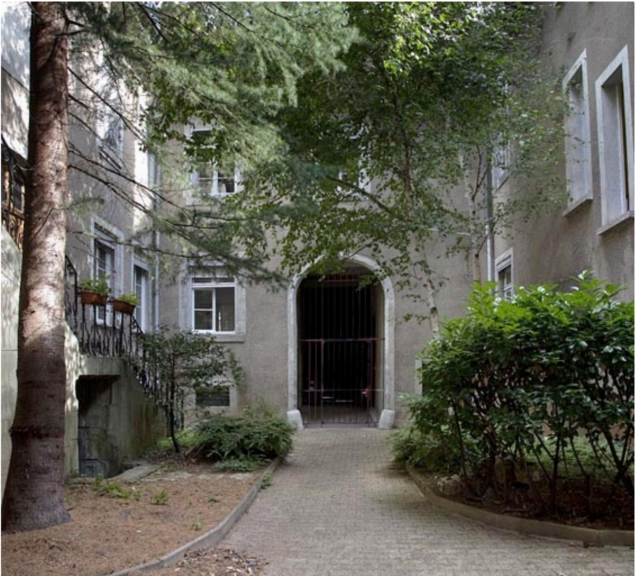
Logis principal, façade postérieure depuis le fond de la cour.
