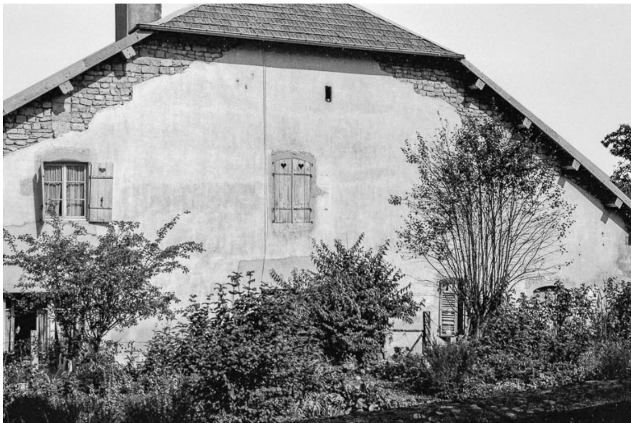
Ferme cadastrée 1961 AC 107 : façade antérieure.
